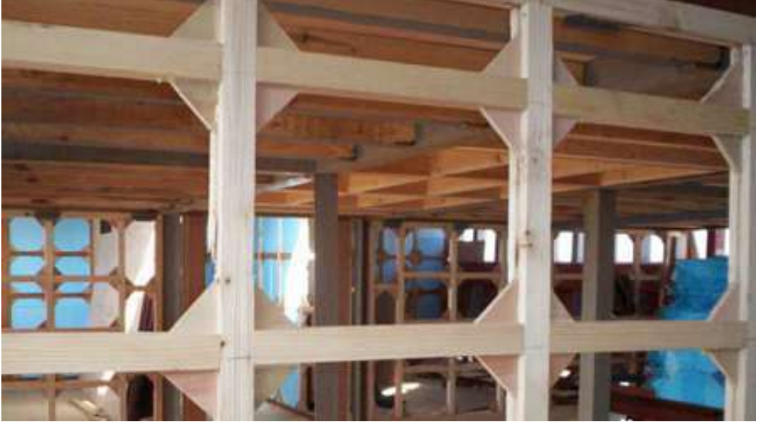
Resim 1.2: Köşe destek takozlu karkas birleştirme
