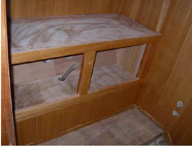
Resim 1.5: Kaplama yapılmış lavoba cephe görünüşü
