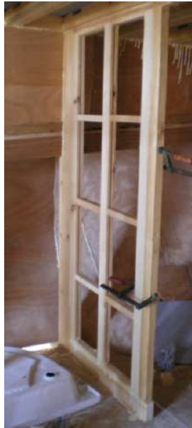
Resim 1.1: Kınışlı karkas birleştirme
