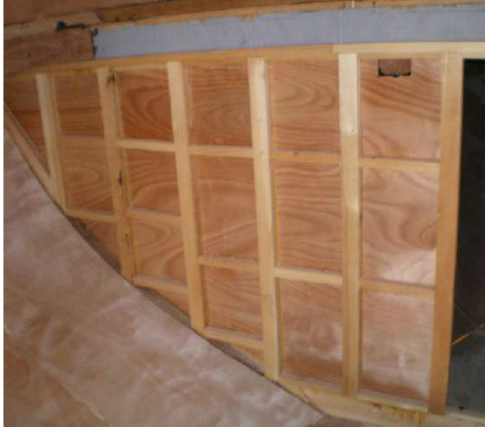
Resim 1.3: Tek yön kaplama yapılmış karkas
