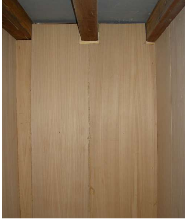
Resim 1.4: Kaplama yapılmış bölme cephesi
