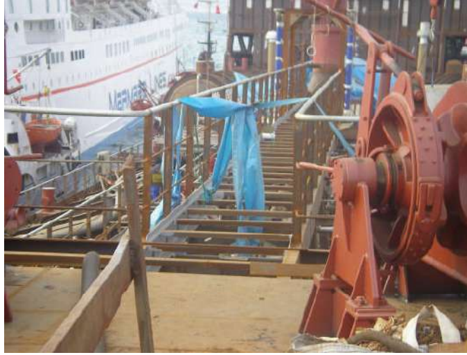
Resim1.2: Kedi köprüsü yapımı ve montajı
