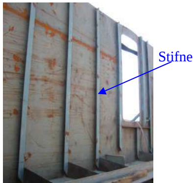
Resim 3.3: Köşebentten kesilmiş stifner
