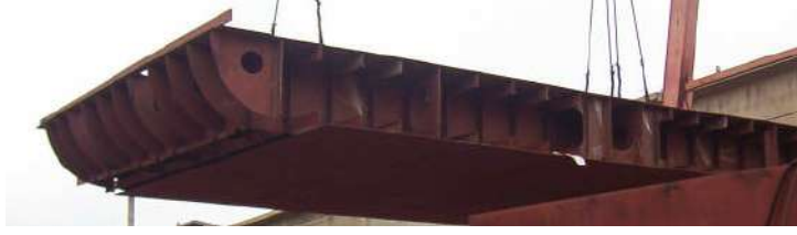
Resim 1.9: Sintine dönümü braketi
