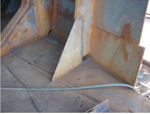
Resim 1.5: Posta braket bağlantısı
