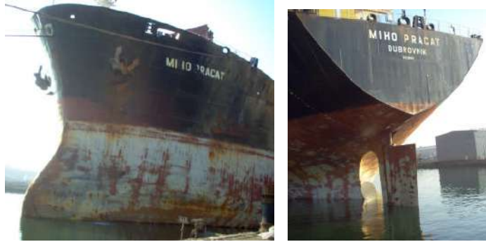
Resim 2.3: Gemi sacının korozyonu
