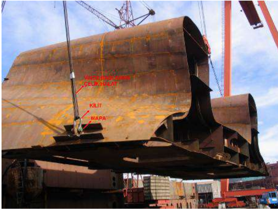
Resim 1.9: Blok kaldırma operasyonu
