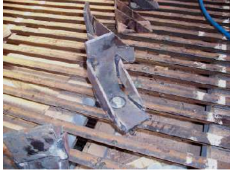
Resim 1.10: Postaların kalıpları
