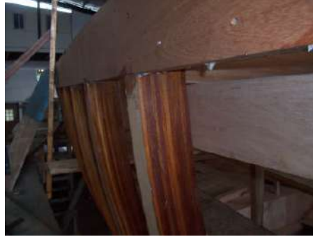
Resim 2.24: Postaların üst kuşağa bağlanması
