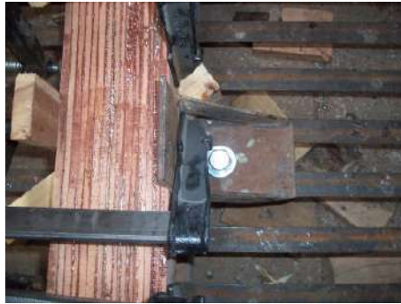
Resim 1.12: Postaların kalıplarda yapıştırılması
