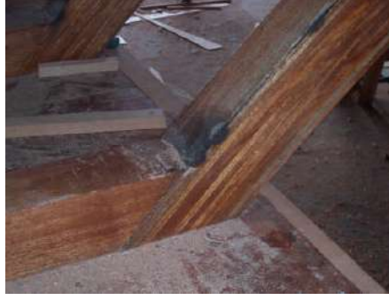
Resim 2.20: Posta-döşek bağlantıları
