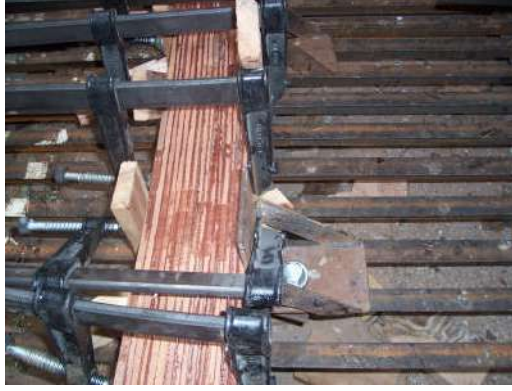
Resim 1.13: Postaların kalıplarda yapıştırılması
