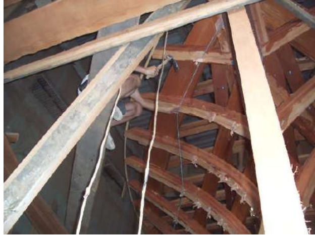
Resim 1.8: Postalara keserle form verilmesi
