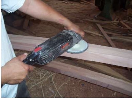
Resim 1.14: Postaların spiralle perdahlanması
