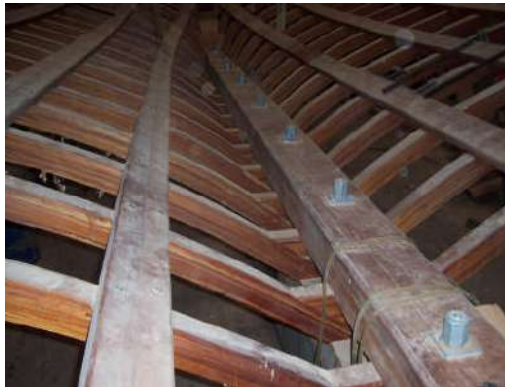
Resim 2.12: Posta yapımında kullanılan cıvata ve somunlar
