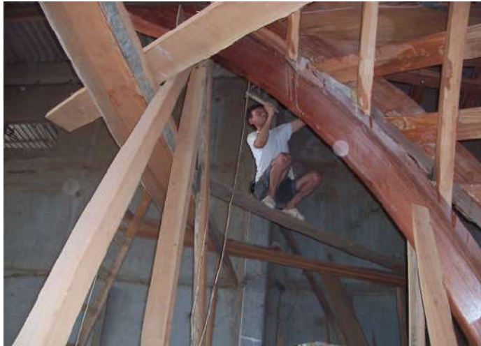
Resim 1.7: Postalara keserle form verilmesi
