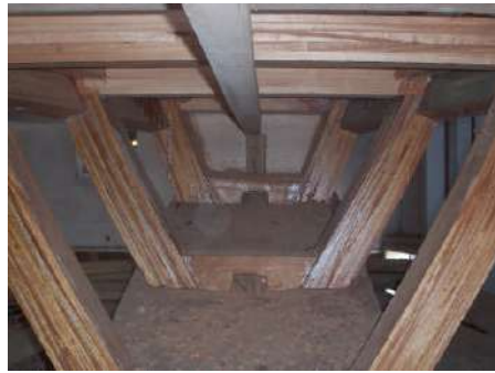
Resim 2.22: Döşeklerin karşılıklı iki postayı birbirine bağlaması
