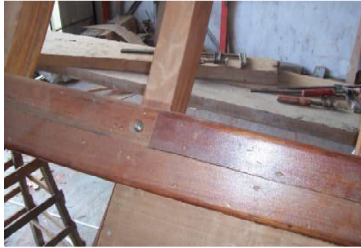
Resim 2.9: Posta yapımında kullanılan çiviler
