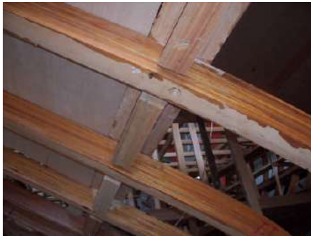
Resim 2.25: Postaların ıstralyalara bağlanması
