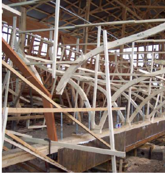
Resim 2.7: Ana omurganın altında metal kalıp içerisine dökülmüş beton salma ve bağlantı saplamaları görülmekte
