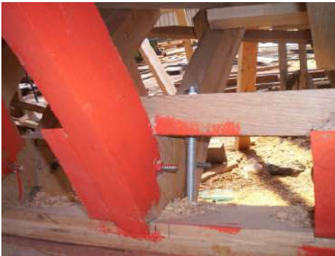
Resim 2.5: İç omurga ve bağlantı elemanları
