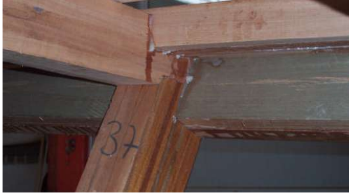
Resim 2.1: Kemere atkısı ve kemere bağlantıları
