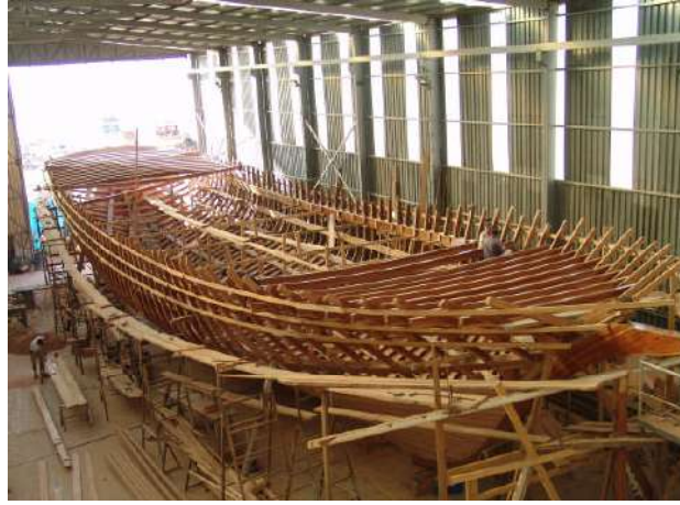
Resim 1.2: Ahşap kemerelerin yerleştirilmesi
