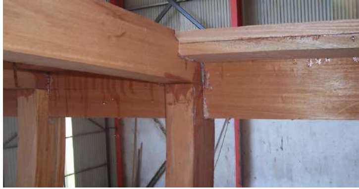
Resim 2.2: Kemere tirizi ve kemere bağlantıları
