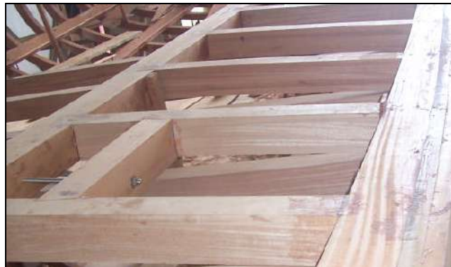
Resim 1.7: Öksüz kemereler
