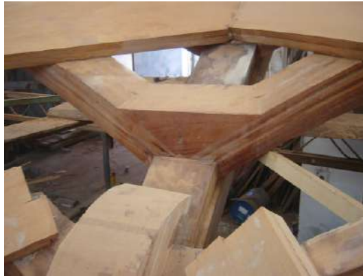
Resim 1.3: Ahşap döşeklerin desteklenmesi
