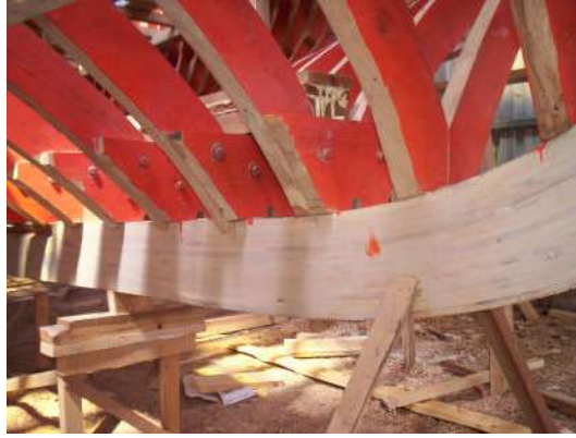
Resim 1.2: Ahşap döşeklerin her postada bir bağlanması
