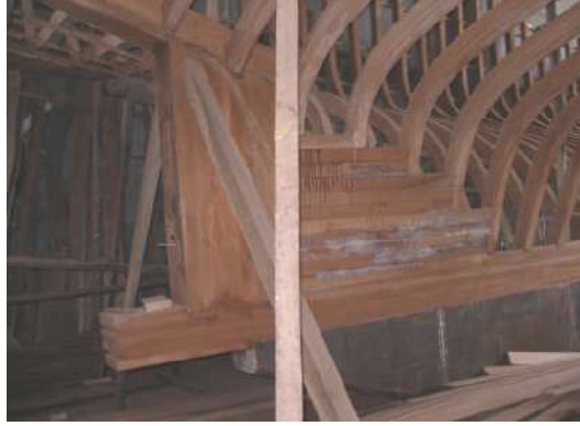
Resim 1.4: Kıç pikte ahşap döşeklerin desteklenmesi
