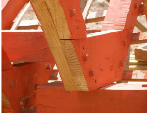
Resim 2.2: Döşek posta bağlantıları
