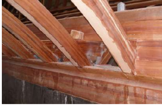
Resim 1.6: Ahşap döşeklerin üst taraftan sotropoyla tekne boyunca desteklenmesi
