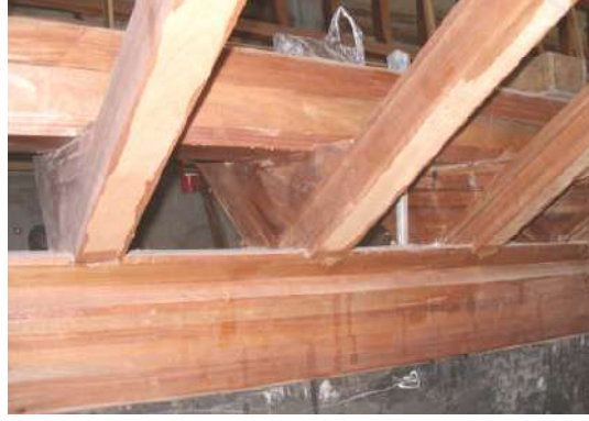
Resim 2.3: Döşek sotropo bağlantıları
